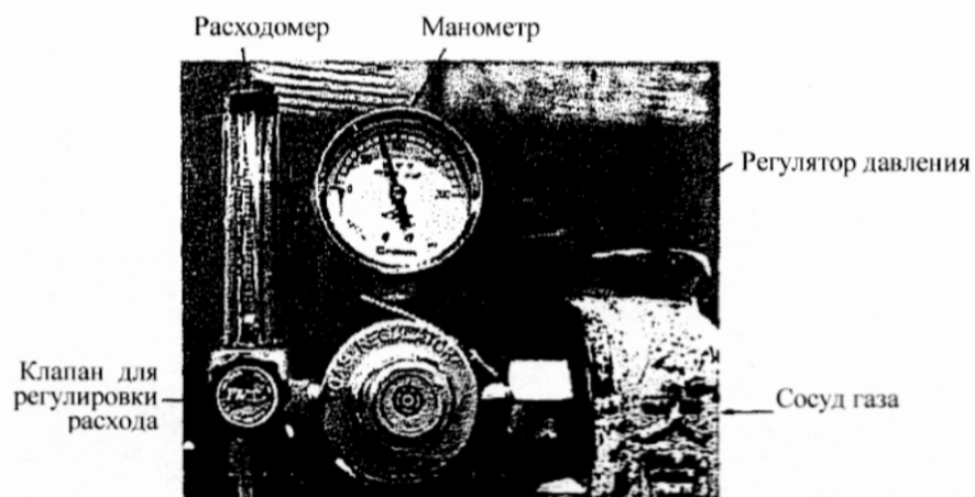
Рис. 2.25 Регулятор давления газа с расходомером
